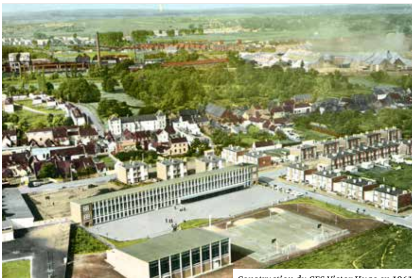
Construction du CES Victor Hugo en 1961
