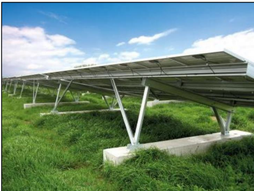
Structure au sol utilisant longrine béton similaire au projet de centrale solaire d'Auby – Source : Nala Renweavles
