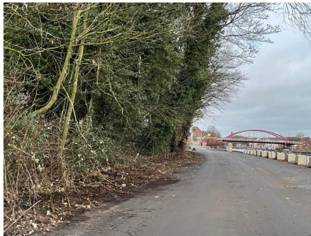
Figure 3: Elagage réalisé sur chemin de halage
